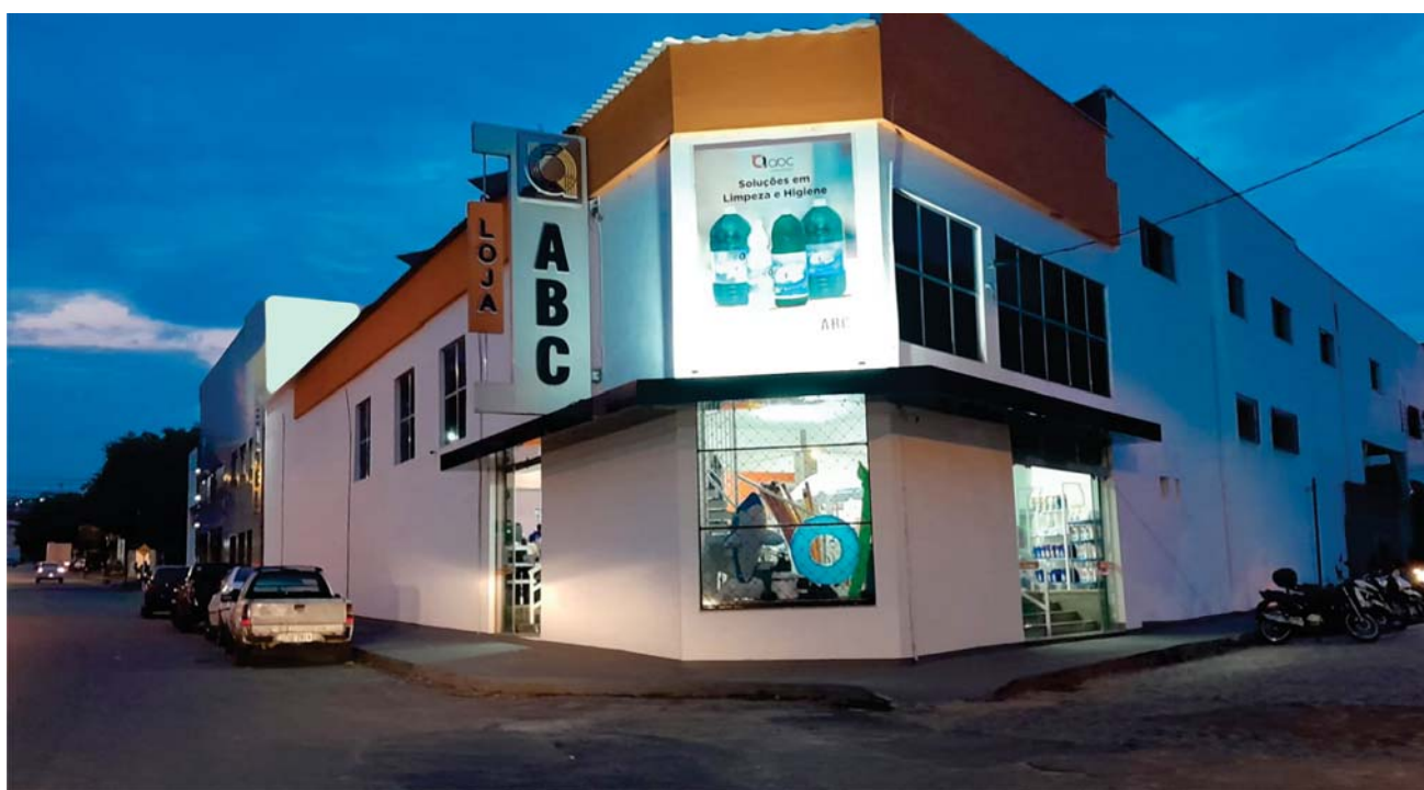
A loja ABC, com a fachada repaginada, junto à sede da ABC
